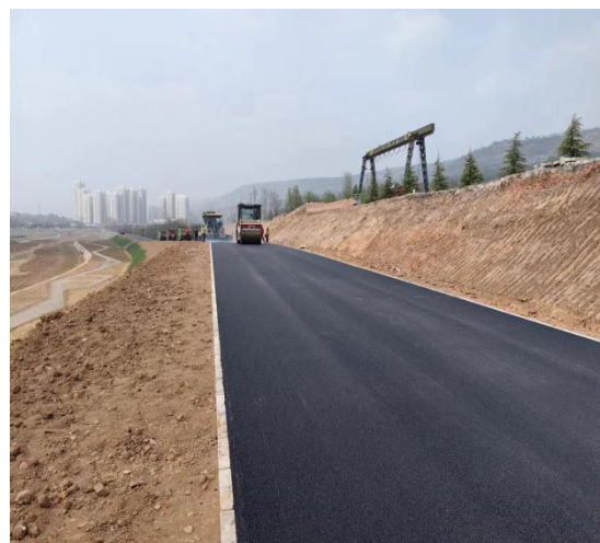
新建堤顶道路
