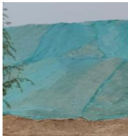
施工中临时苫盖
