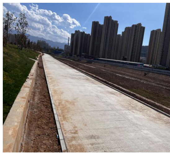
新修堤顶道路
