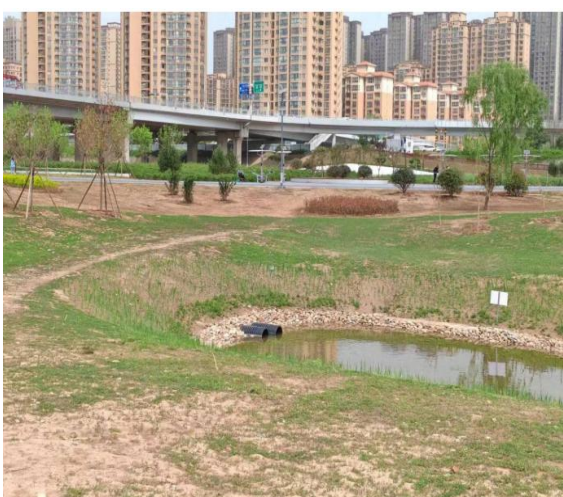
人工水系池连通管出水口
