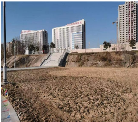
施工中土地整治
