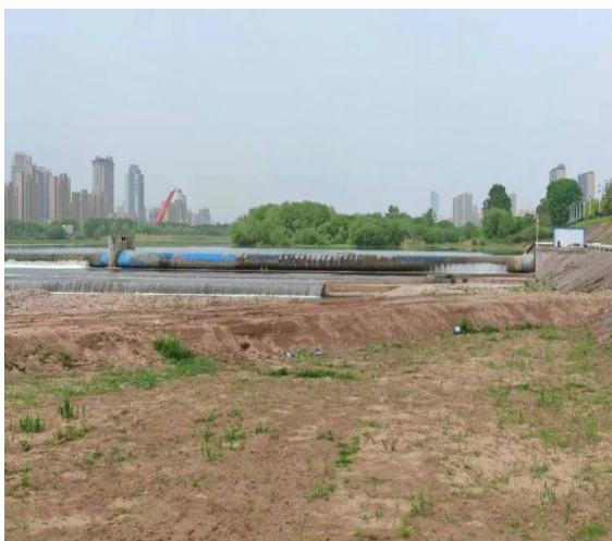
顶冲首段回填区域
