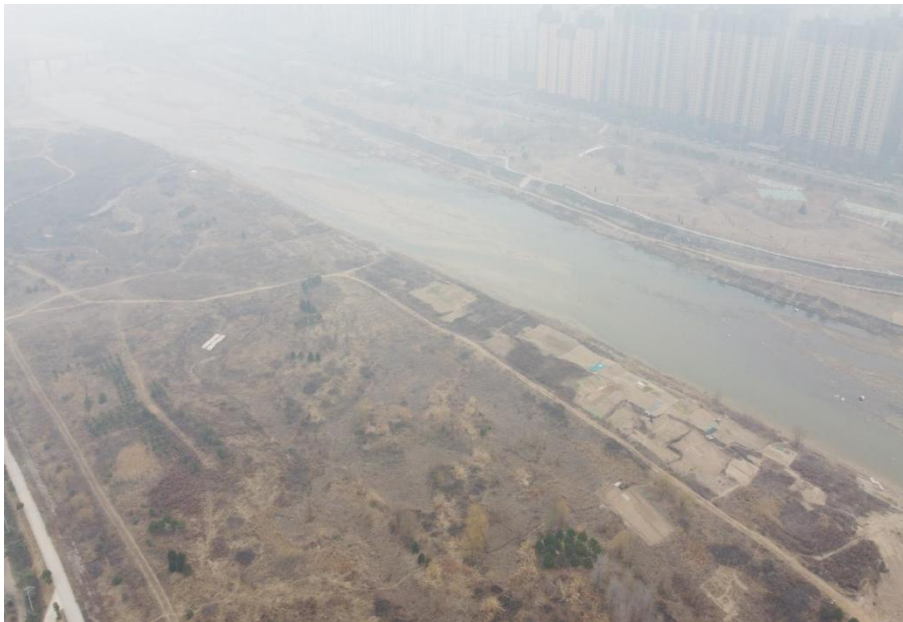
钛谷大桥东侧向下游建设前（2023年3月）
