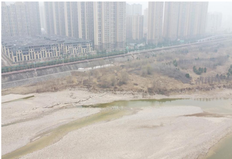
项目起点建设前（2023年3月）
