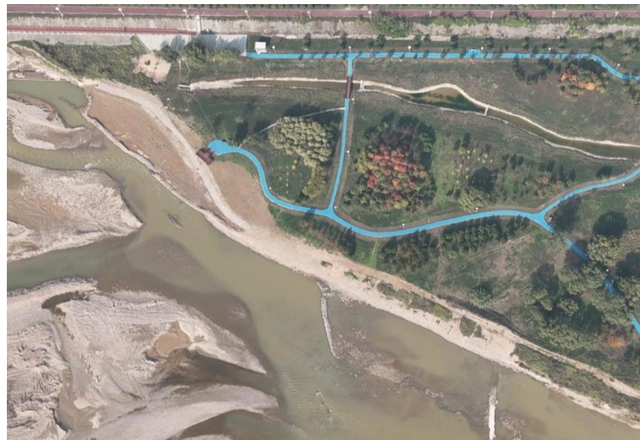
项目起点建设后（2024年11月）
