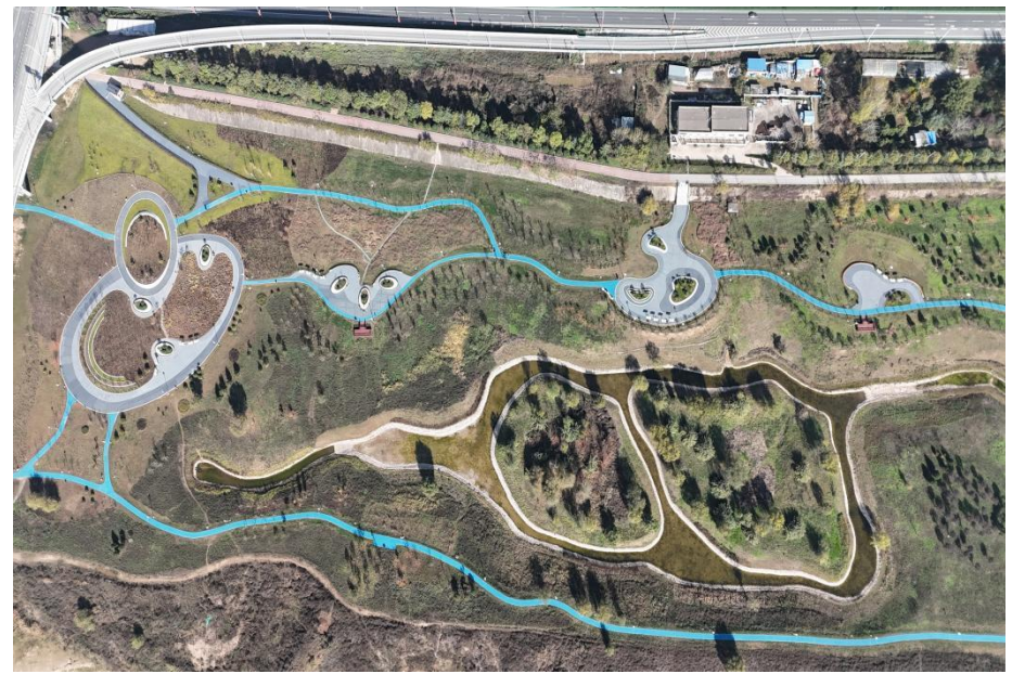
钛谷大桥东侧向下游建设后（2024年11月）
