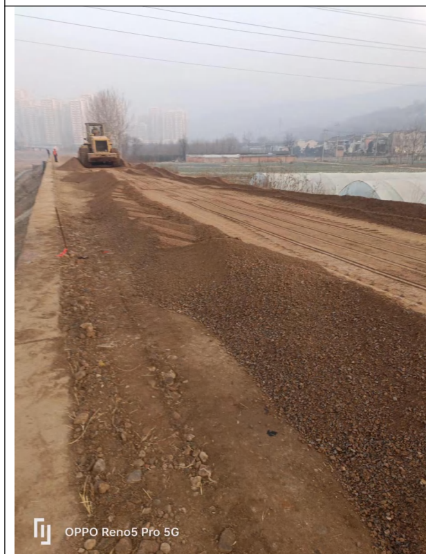
2-1 堤顶硬化道路建设中
