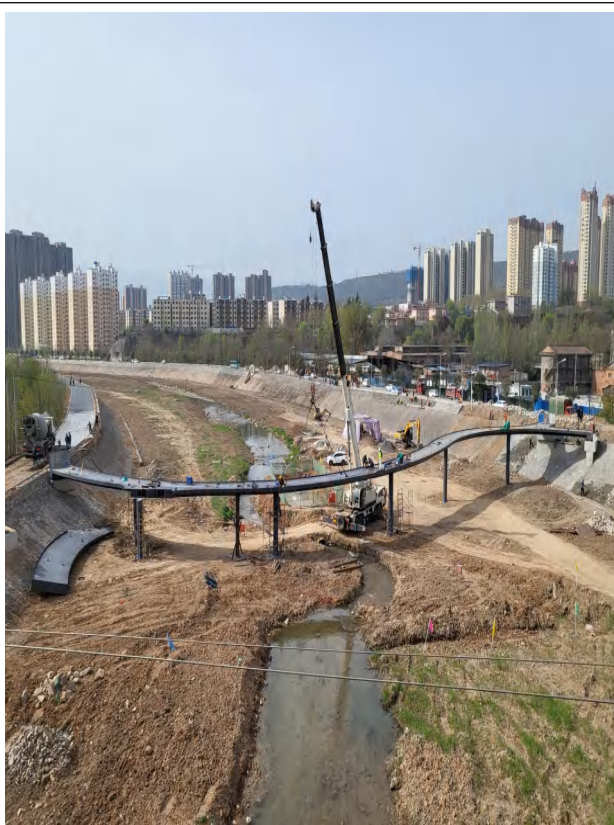
7-1 人行桥建设中
