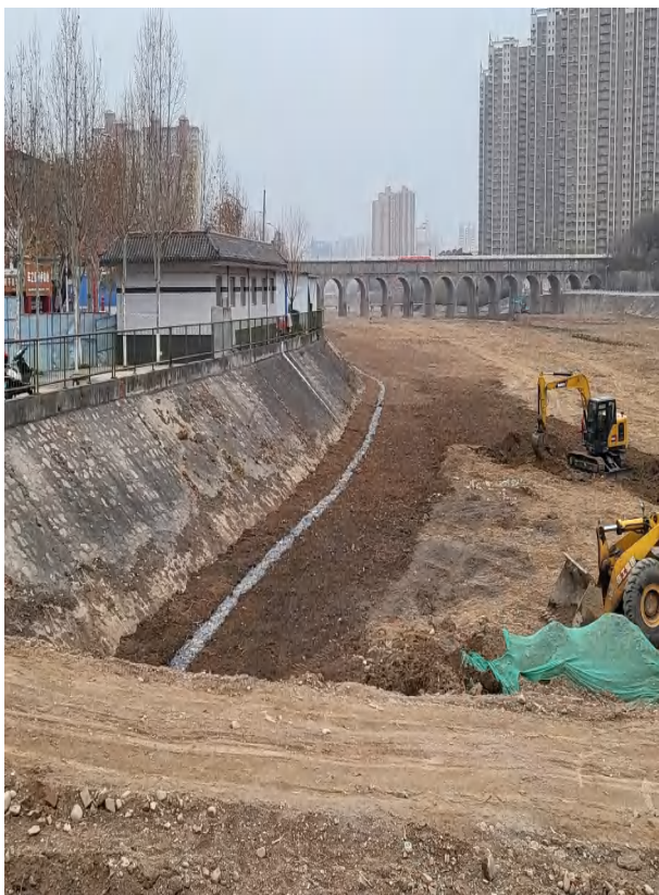
5-1 水生态修复工程施工中
