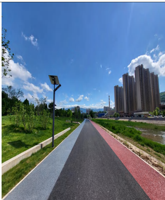
2-2 已建成堤顶硬化道路
