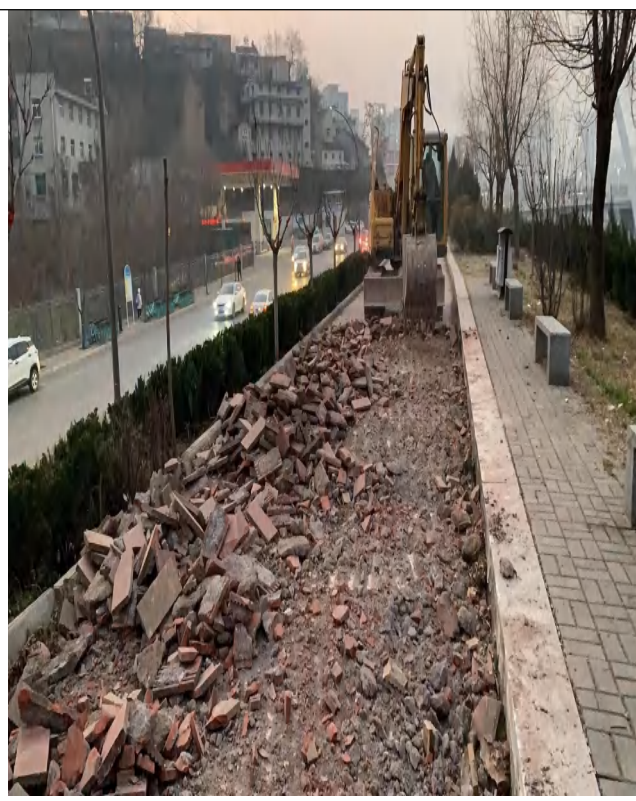
2-1 堤顶硬化道路建设中
