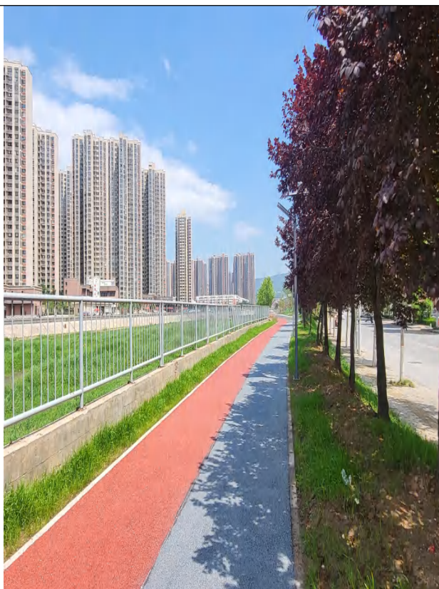
2-2 已建成堤顶硬化道路
