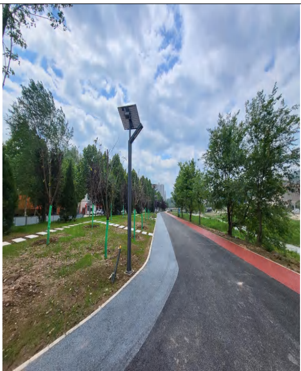
2-2 已建成堤顶硬化道路
