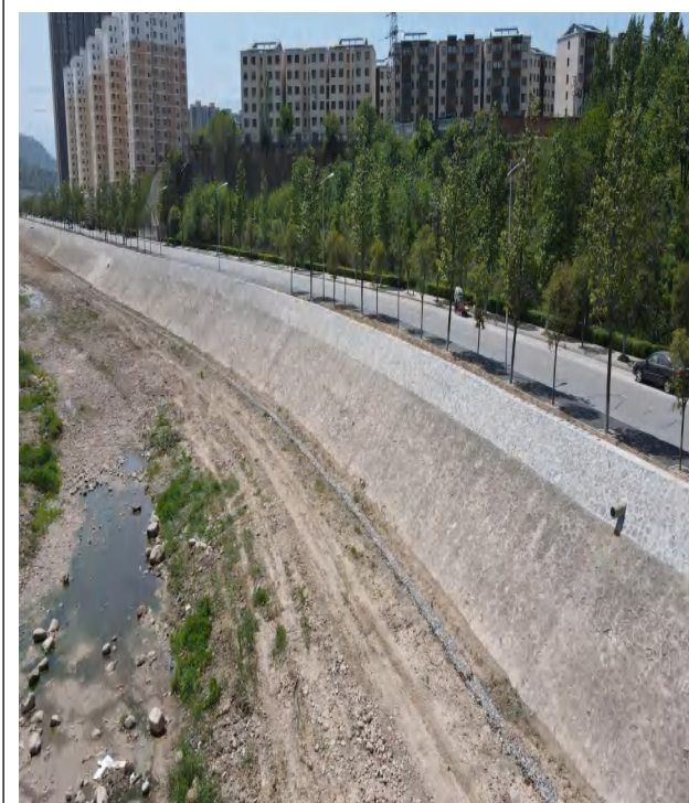
3-2 已建成生态岸坡
