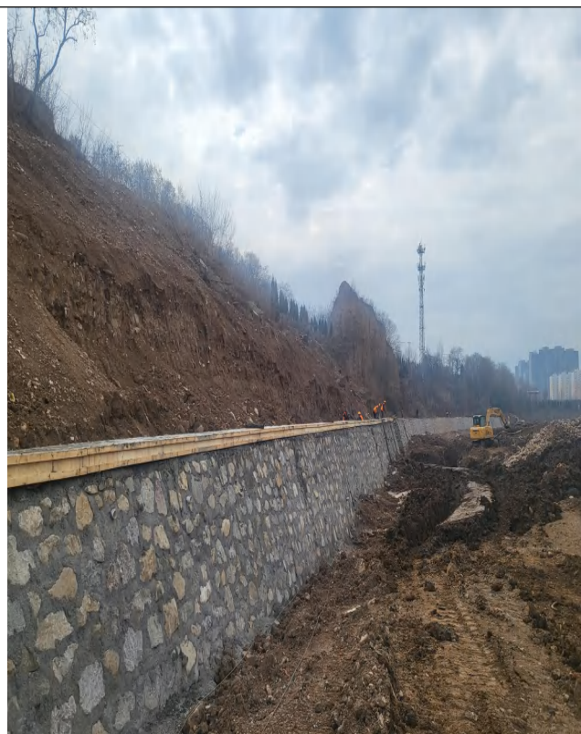
1-1 建设中护岸工程
