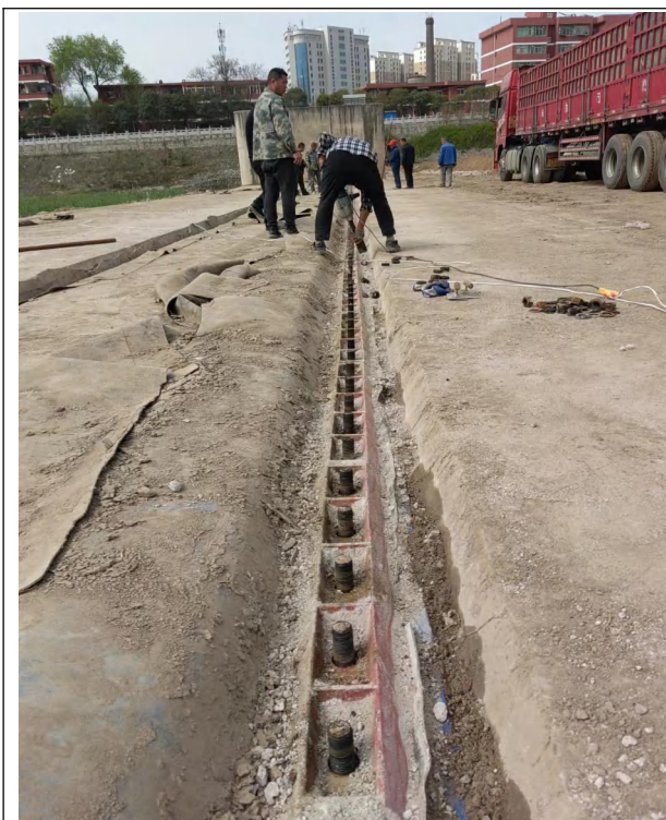
8-1 橡胶坝建设中
