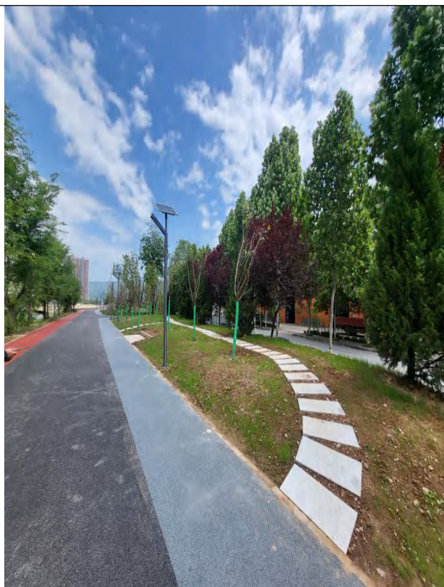
2-2 已建成堤顶硬化道路
