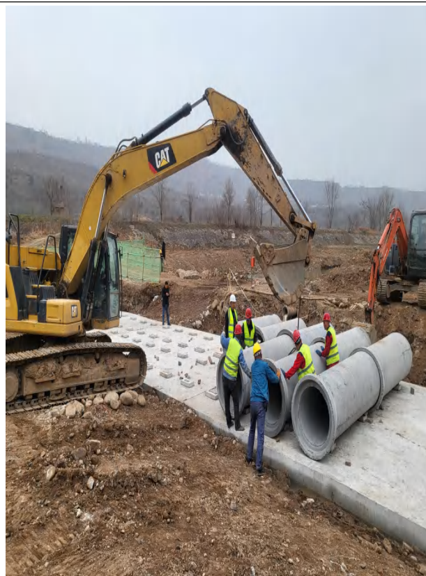
7-1 漫水桥建设中
