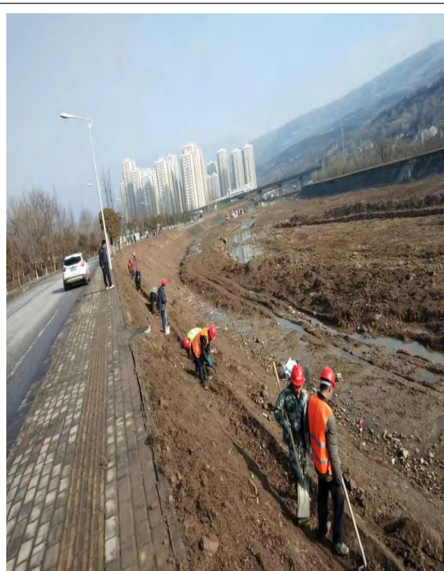
3-1 生态岸坡建设中
