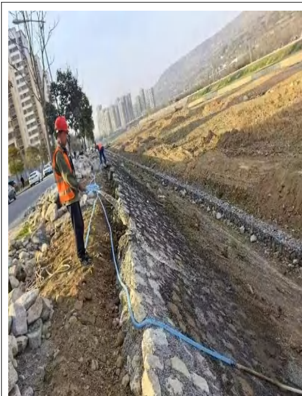
3-1 生态岸坡建设中
