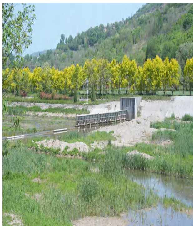
8-1 液压坝建设中
