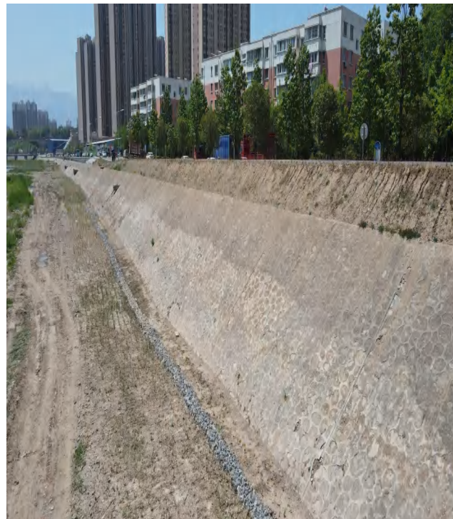
3-2 已建成生态岸坡
