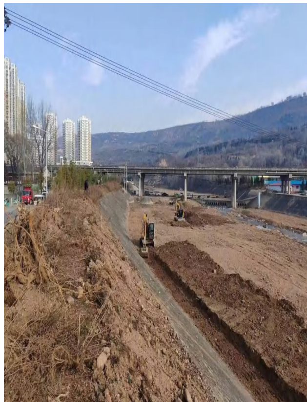
5-1 水生态修复工程施工中
