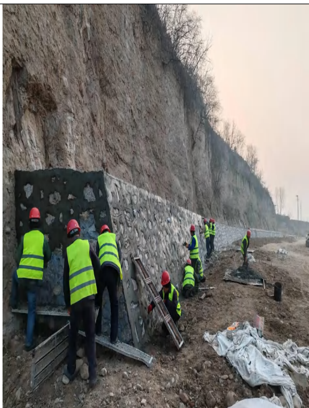
1-1 建设中护岸工程
