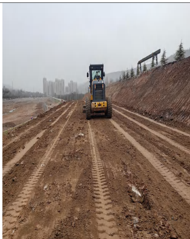
2-1 堤顶硬化道路建设中
